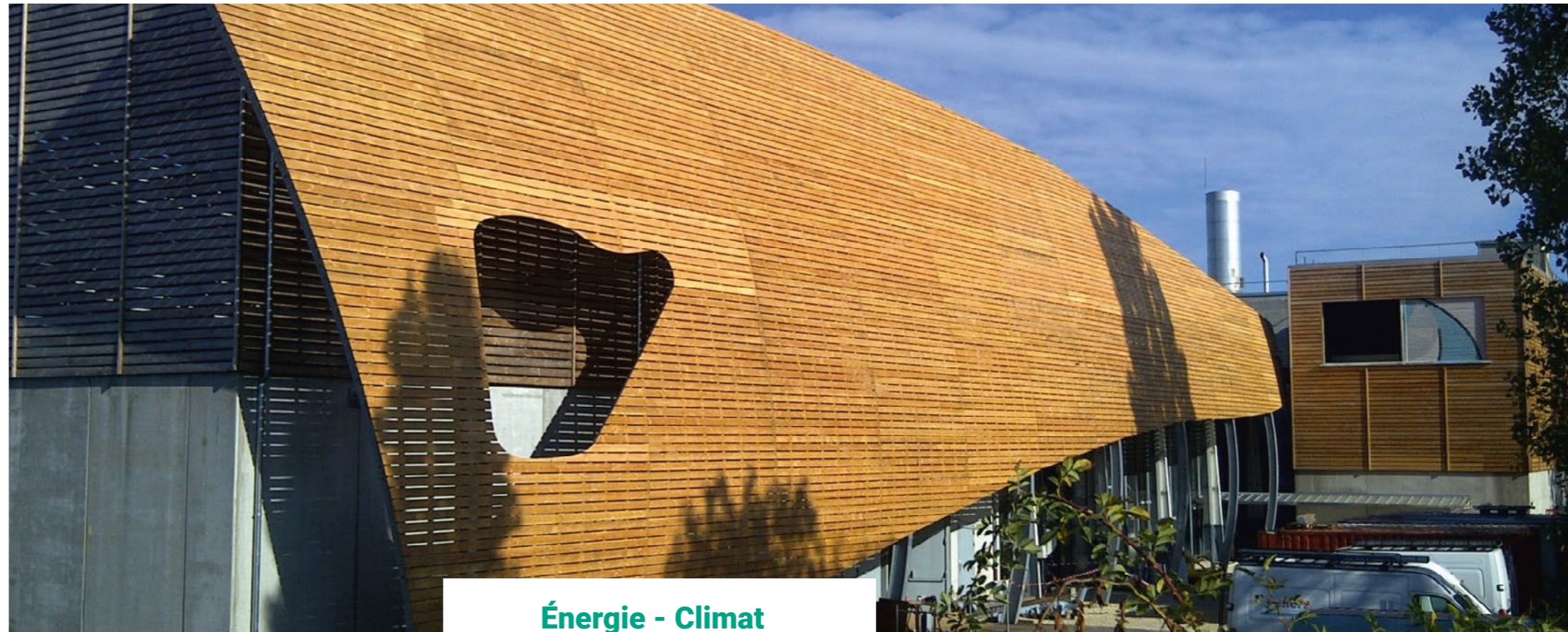
Chaufferie de Dole
