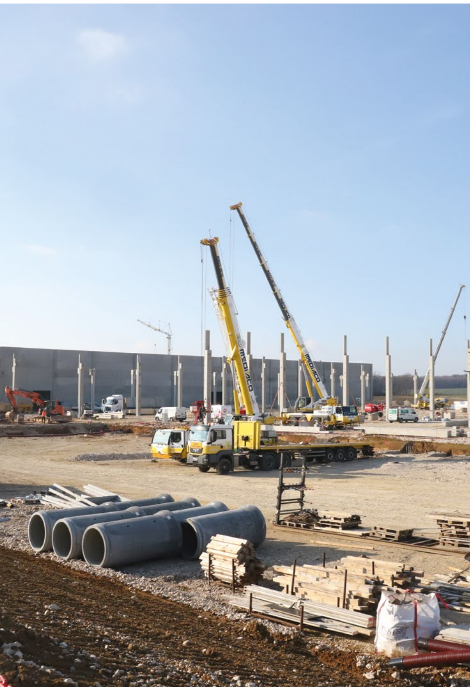
Chantier de la zone logistique ITM à Rochefort-sur-Nenon
