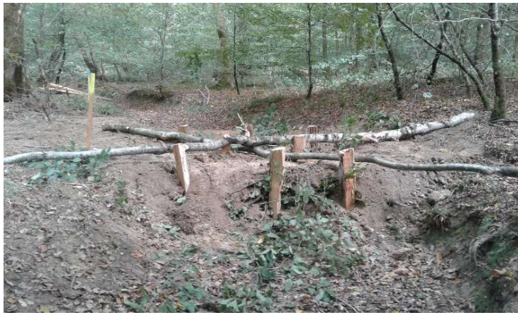
Travaux de restauration de la Clauge
