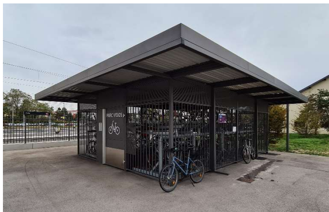
Abri à vélo sécurisé sur le parvis de la gare
