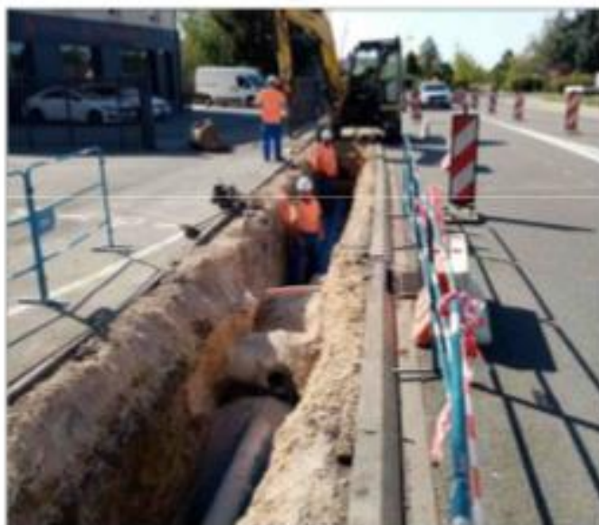
En septembre, un tronçon du réseau a été changé avenue de la République. Photo Progrès/Patrice DUCORDEAUX
