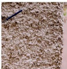
Exemple d'enduit brut de projection dit rustique Mise en œuvre jetée ou brossée
